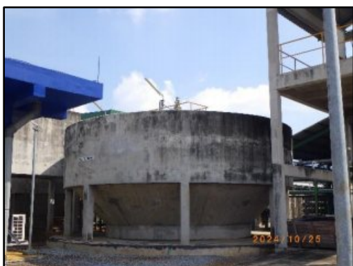
รูปที่ 2-14 บ่อรวบรวมน้ำทิ้ง (Retention Tank)
