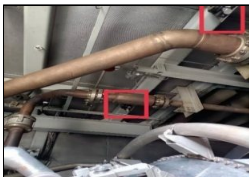
Gas Detector บริเวณ Gas Turbine 1
