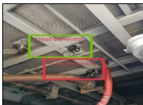
Gas Detector บริเวณ Gas Turbine 2
