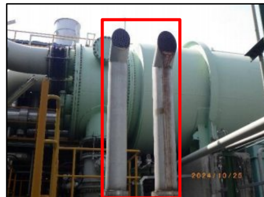
รูปที่ 2-11 อุปกรณ์ลดเสียง (Silencer)
