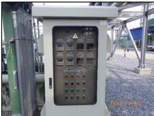
รูปที่ 2-17 ระบบตรวจวัดคุณภาพน้ำจากหอหล่อเย็นแบบต่อเนื่อง
