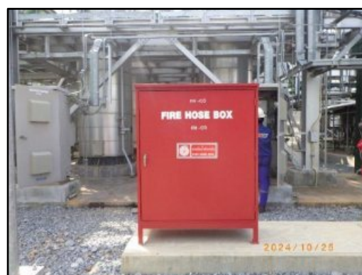
รูปที่ 2-48 ตู้หัวฉีดดับเพลิง บริเวณ Gas Turbine และ Gas Engine
