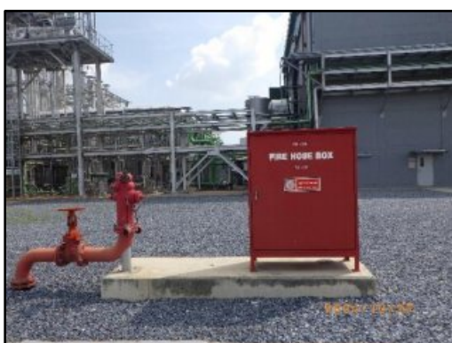
รูปที่ 2-48 ตู้หัวฉีดดับเพลิง บริเวณ Gas Turbine และ Gas Engine
