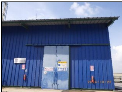
รูปที่ 2-10 อาคารปิดคลุมเครื่องจักรที่มีเสียงดัง
