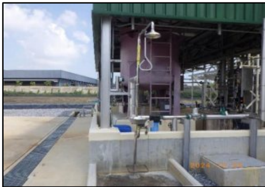
รูปที่ 2-54 อ่างล้างตาฉุกเฉิน และฝักบัวชำระร่างกายในบริเวณกระบวนการผลิต และอาคารเก็บวัตถุดิบและสารเคมี
