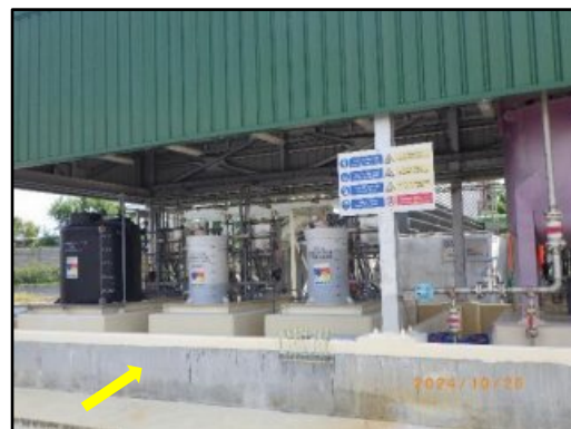
รูปที่ 2-56 คันคอนกรีตบริเวณพื้นที่จัดเก็บสารเคมี
