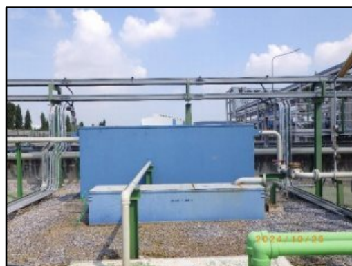
รูปที่ 2-15 ถังแยกน้ำ-น้ำมัน (Oil Separator)
