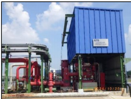
รูปที่ 2-50 ปิมน้ำดับเพลิง
