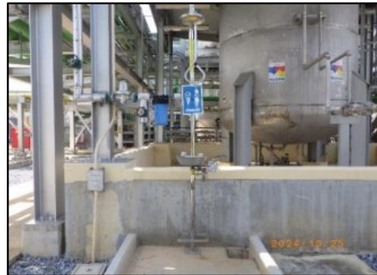
รูปที่ 2-54 อ่างล้างตาฉุกเฉิน และฝักบัวชำระร่างกายในบริเวณกระบวนการผลิต และอาคารเก็บวัตถุดิบและสารเคมี
