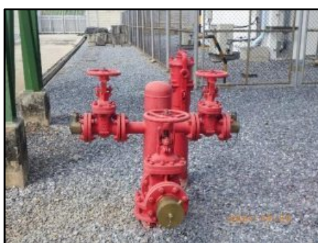
รูปที่ 2-50 ปิมน้ำดับเพลิง
