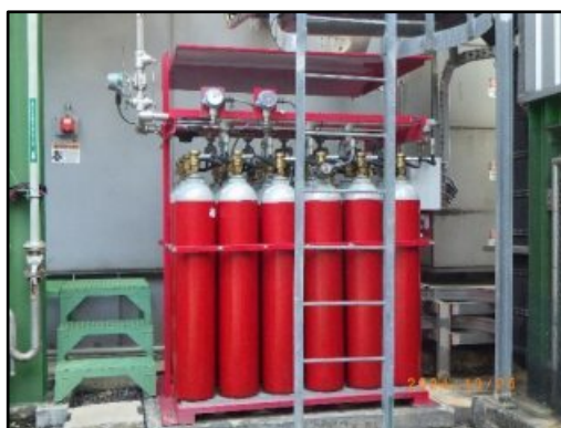
รูปที่ 2-47 ระบบดับเพลิงแบบใช้ก๊าซคาร์บอนไดออกไซด์ CO 2 บริเวณ Gas Turbine
